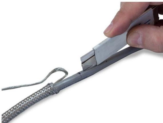
**Figura A-34:** Cortando ao longo da camisa de cabo
