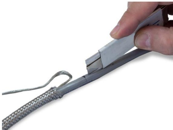
**Figura A-34: taglio longitudinale della guaina del cavo**
